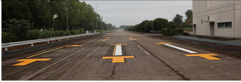
写真 2-7-18 予備実験（踏切内）の誘導表示等の敷設状況
