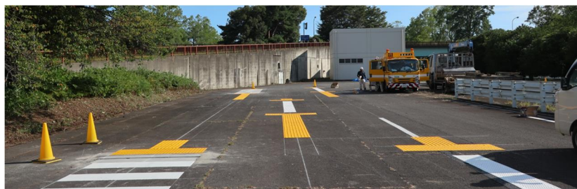
写真 2-7-17 予備実験（踏切手前部）の誘導表示等の敷設状況
