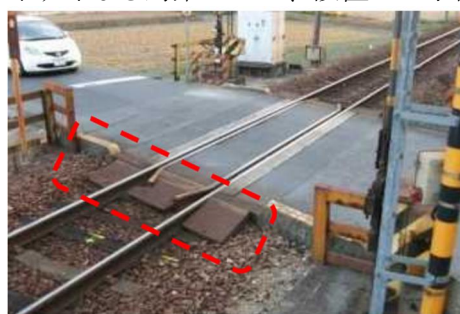
写真 2-7-33 スロープの設置事例
