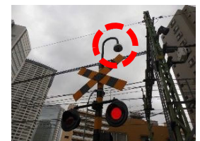
踏切監視用カメラ
