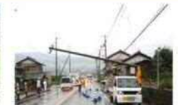
沿道の電柱の倒壊による道路閉塞
