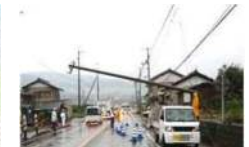
沿道の電柱の倒壊による道路閉塞
