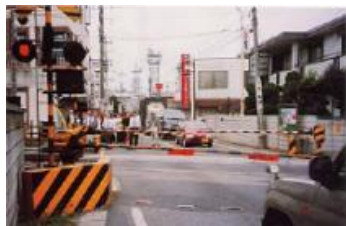
遮断機・警報機
