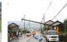
沿道の電柱の倒壊による道路閉塞
