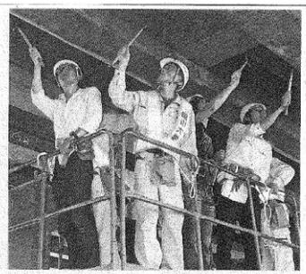
橋桁を打音検査する学生ら
