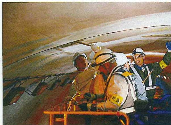
高所作業車を用いた近接目視・打音点検
