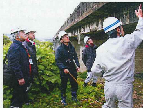
合同現地確認状況
