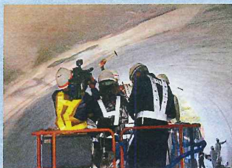
実際に壁面をたたいて 異常がないか確認
