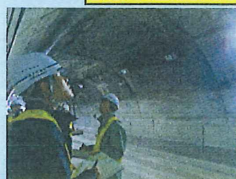
近接、遠望目視による点検
