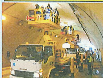
覆工上部を近接目視
