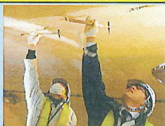
点検ハンマーによる打音点検
