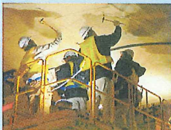
高所作業車による近接目視
