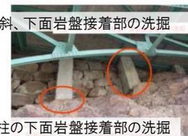
Co支柱の下面岩盤接着部の洗掘
