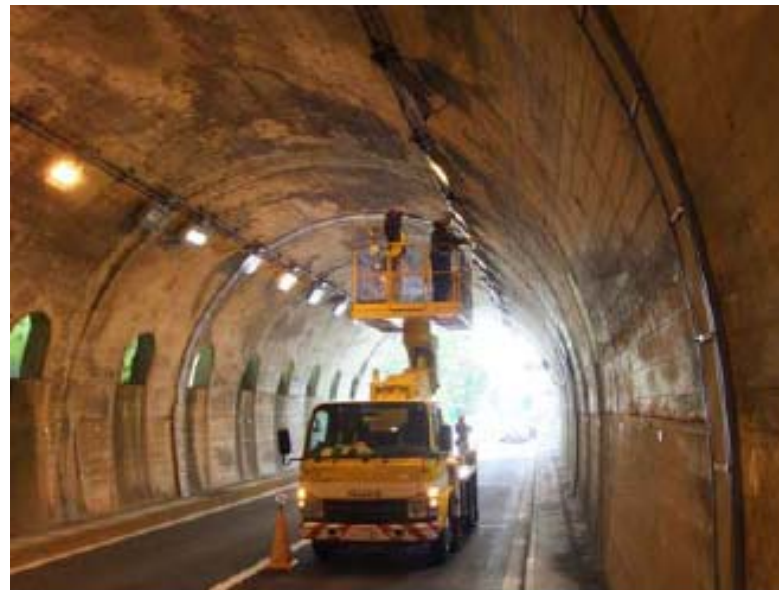
近接目視作業状況
