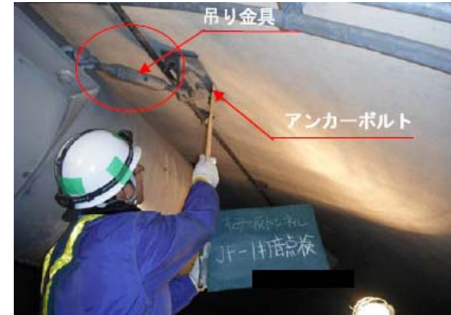
打音調査作業状況
