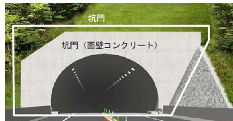
別図-1.2 点検対象箇所(トンネル坑口部)
