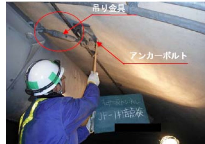
打音調査作業状況
