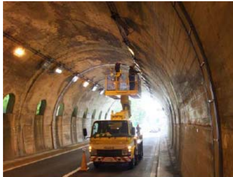
近接目視作業状況
