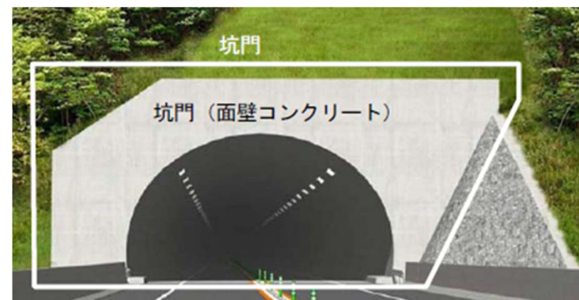
別図-1.2 点検対象箇所(トンネル坑口部)
