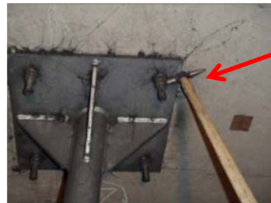
打音検査の例
