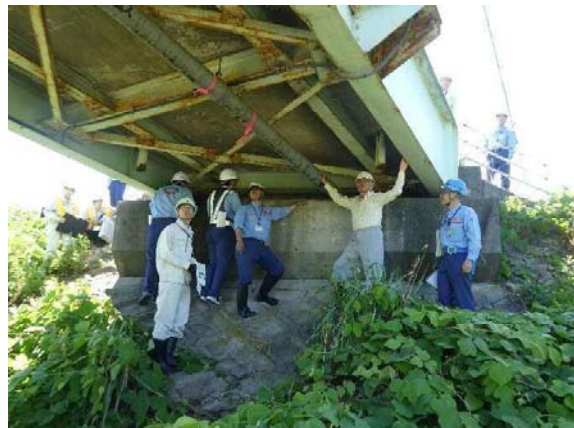
重篤損傷発生時の緊急点検
