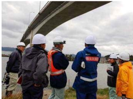
松江市管理 中海大橋 令和元年11月26日
