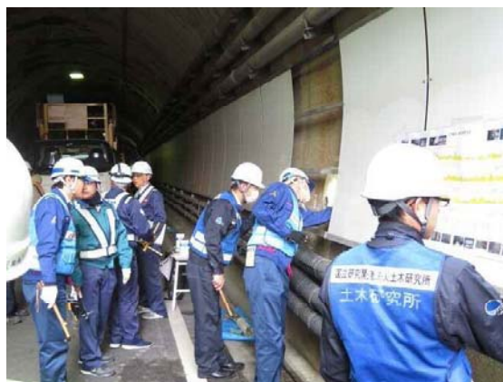
道路メンテナンス技術集団による調査・診断 (道路メンテナンス技術集団)
