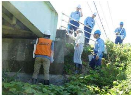
米子市管理 安養寺橋 令和元年6月13日
