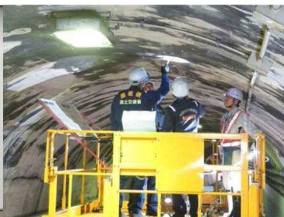
覆工コンクリートの状態を確認 (道路メンテナンス技術集団)
