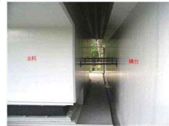
桁端部遊間確保と塗装事例
