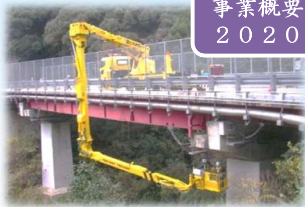
＜橋梁点検車による点検＞
