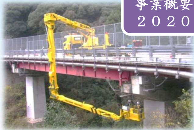
＜橋梁点検車による点検＞
