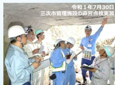
＜直営点検の実習風景＞
