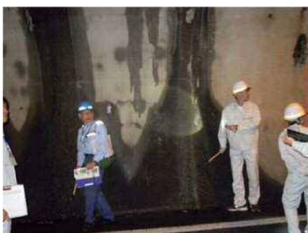
安芸大田町管理 筒賀隧道 令和元年10月11日
