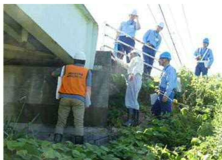
米子市管理 安養寺橋 令和元年6月13日
