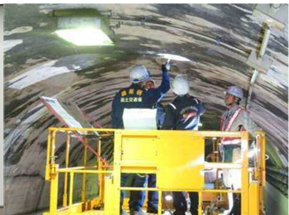
覆工コンクリートの状態を確認 (道路メンテナンス技術集団)
