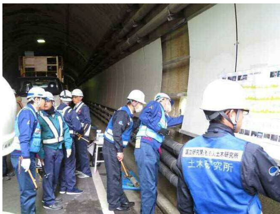
道路メンテナンス技術集団による調査・診断 (道路メンテナンス技術集団)
