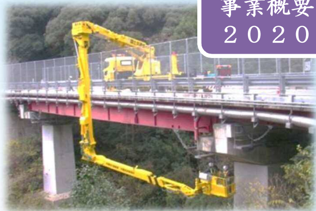
＜橋梁点検車による点検＞
