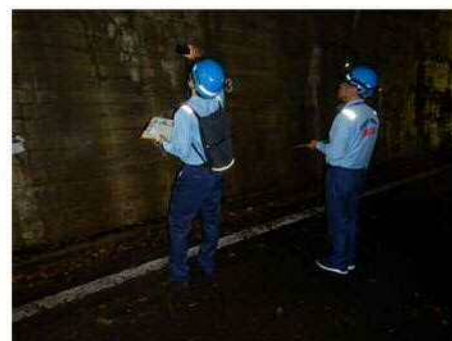
安芸大田町管理 水梨隧道 令和元年10月11日
