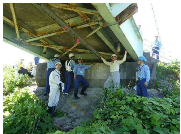
重篤損傷発生時の緊急点検
