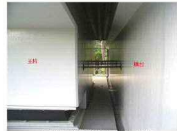
桁端部遊間確保と塗装事例
