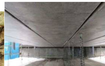
床版打ち換え
