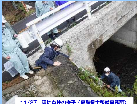
11/27 現地点検の様子（鳥取県土整備事務所）
