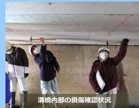
溝橋橋面の損傷確認状況
