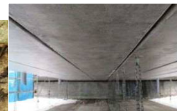
床版打ち換え
