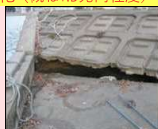
クラックが生じた河川護岸 早期に措置が必要な施設の例
