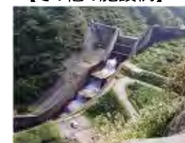
砂防施設 (砂防堰堤)
