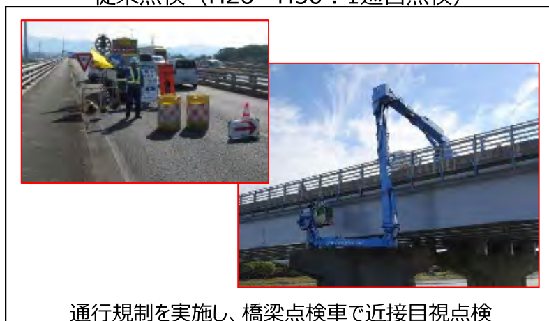
従来点検（H26～H30：1巡目点検）
