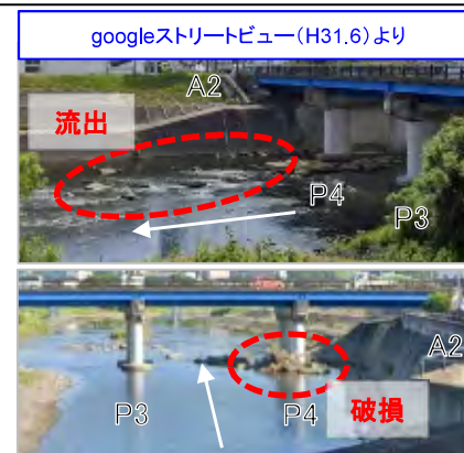
護床工の破損・流出(定期点検前)
