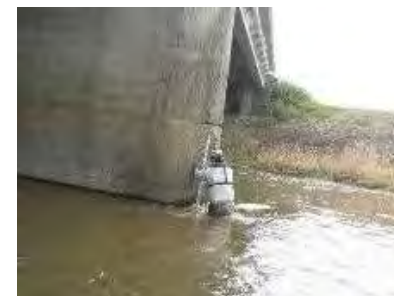
手作業による 下部工洗掘削状況の計測
