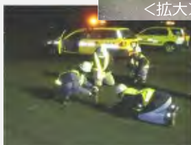
&lt;わだち掘れ計測&gt;
