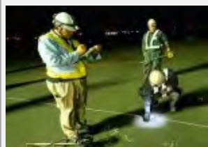
&lt;ひび割れ計測&gt;
