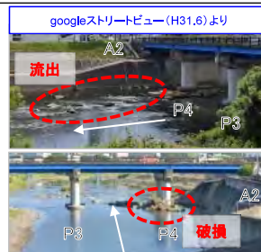
護床工の破損・流出(定期点検前)
