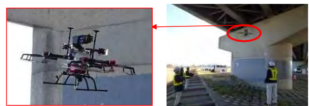
ドローンにより写真を撮影し画像から損傷を確認
