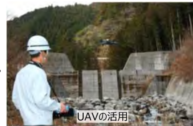
UAVを活用し、効率的・効果的な施設点検へ転換
