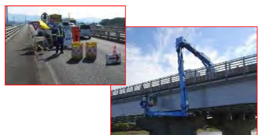
通行規制を実施し、橋梁点検車で近接目視点検
