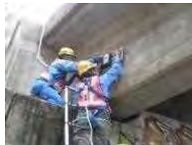
磁気による鋼材密度を測定し内部の損傷を把握
