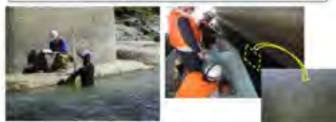
▲潜水士による洗掘調査 ▲水中カメラによる定期点検
