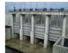
海岸保全施設 (水門)
