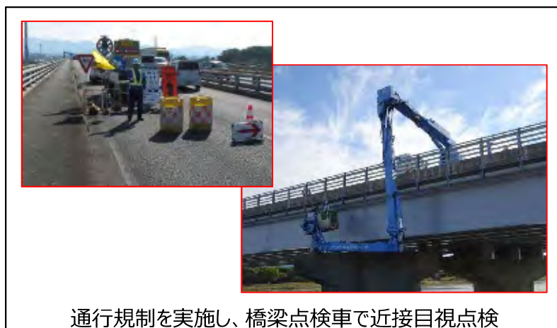
従来点検（H26～H30：1巡目点検）
