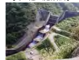
砂防施設 (砂防堰堤)
