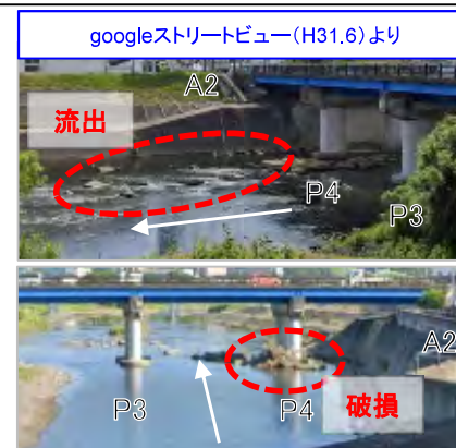
護床工の破損・流出(定期点検前)
