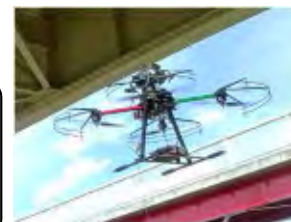
ドローンによる損傷把握
