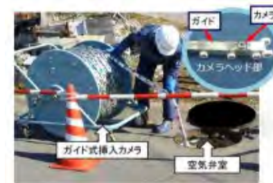
ガイド挿入式カメラを使った調査風景
