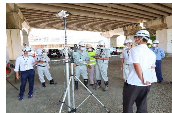
ロボットカメラを用いた点検B
