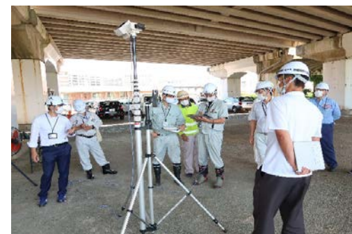
ロボットカメラを用いた点検B
