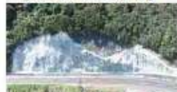
法面吹付工、落石防止網工
