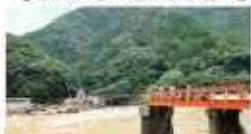
令和2年7月豪雨、熊本県道
