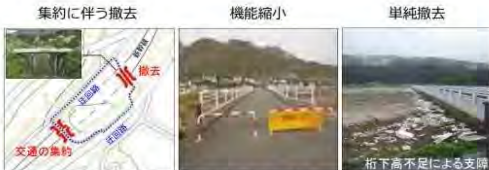
跨線橋を撤去し、隣接橋へ機能を集約
