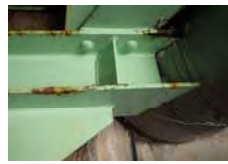
[縦桁の腐食]
