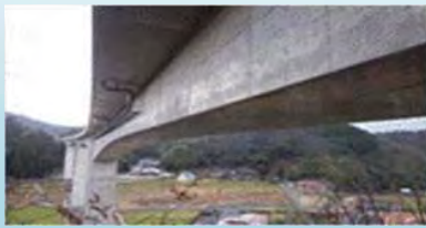
桁高の高い箱桁内部
