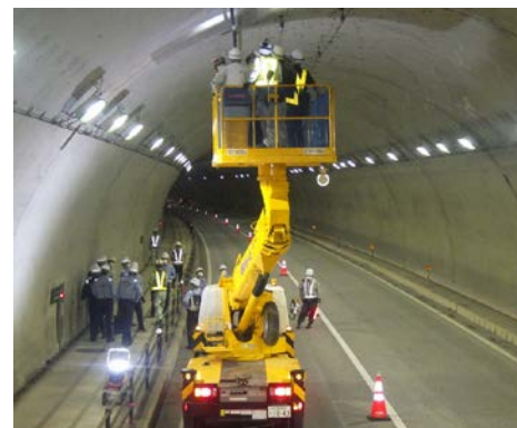
トンネル点検講習会の現地実習
