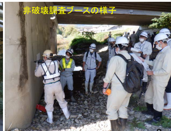
点検支援技術ブースの様子
