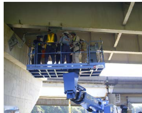
橋梁点検勉強会の現地実習
