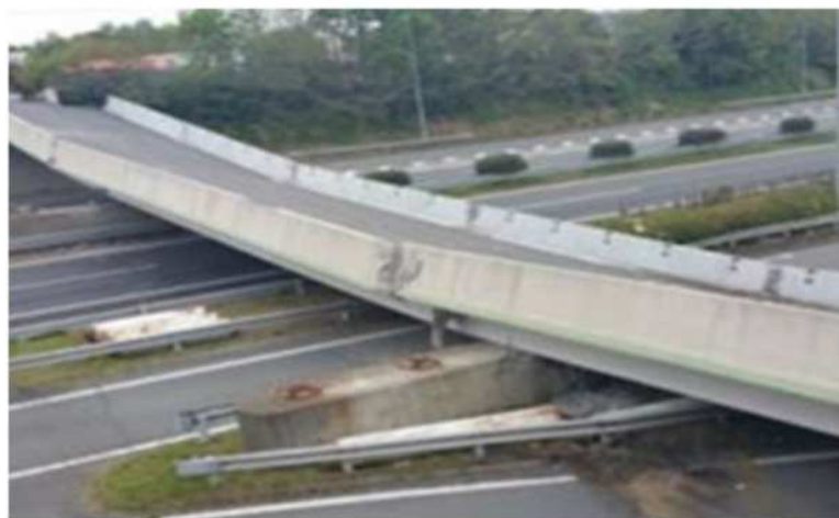
【参考】地震により高速道路に落橋した跨道橋
