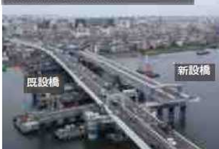
①新設橋設置前（撮影日：R5.5.26）
