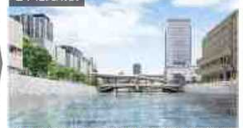
地下化完成後
