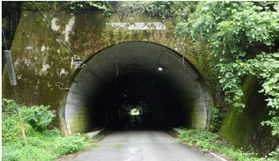
藤ヶ峠トンネル
