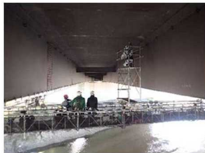
河川上 (移動式足場)
