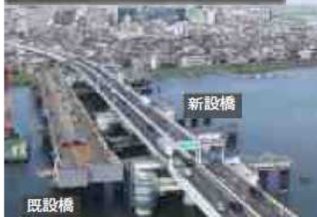
②新設橋設置後（撮影日：R5.9.27）
