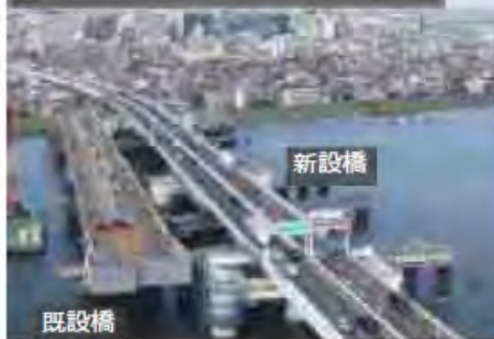
②新設橋設置後（撮影日：R5.9.27）
