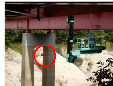
ドローン使用状況
