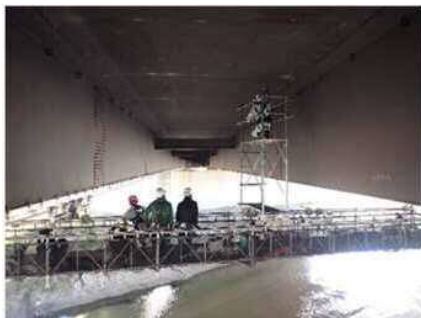
河川上（移動式足場）
