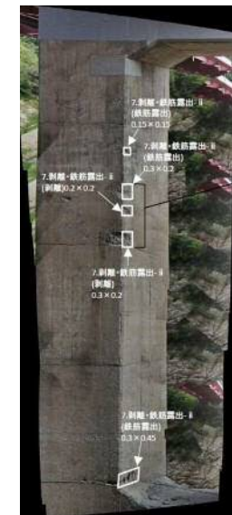
ひびわれ解析結果 及び合成画像
