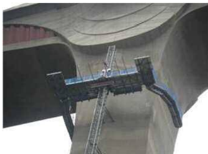
高橋脚（昇降式足場やロープアクセス）
