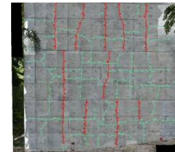
橋脚損傷図
