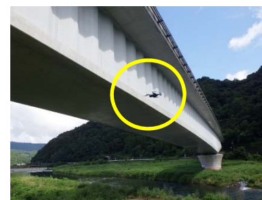
ドローン(J2)点検状況
