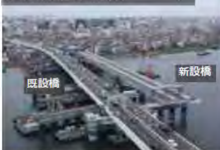
①新設橋設置前（撮影日：R5.5.26）
