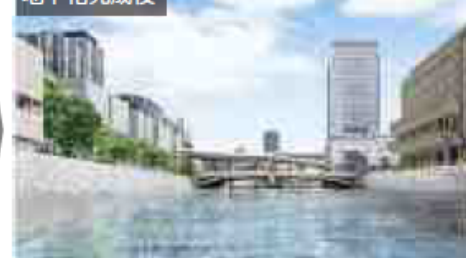
地下化完成後
