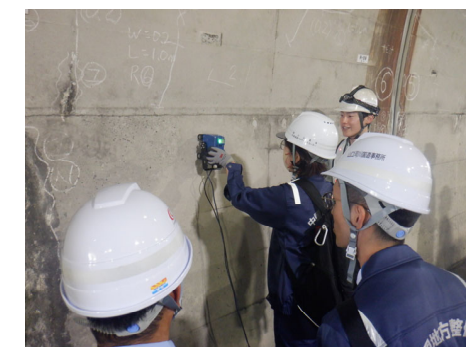
トンネル点検勉強会（現地実習）の実施状況
