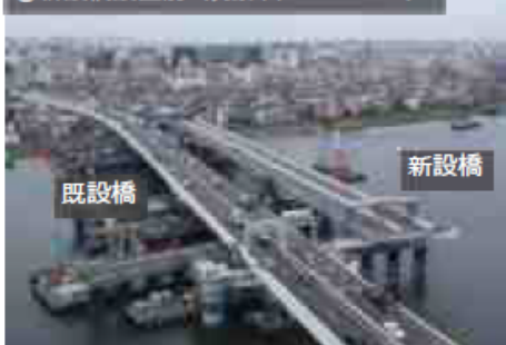
①新設橋設置前（撮影日：R5.5.26）
