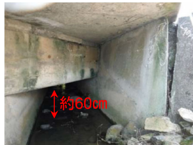
1-1径間の現地状況
