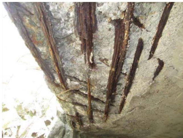
国管理 床版鉄筋露出 ※床版: 橋の裏側
