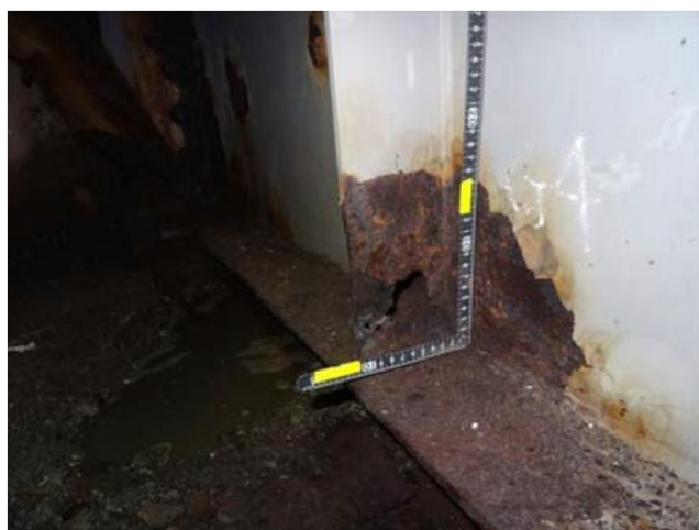
国管理 主桁腐食・欠損
