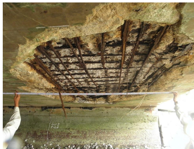
地方自治体管理 13 床版鉄筋露出
