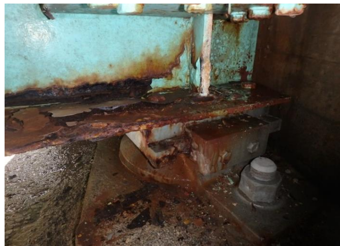
地方自治体管理 主桁腐食
