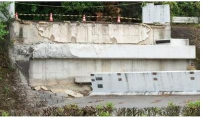
写真-2 横変位拘束構造の破壊、落橋(県道小川嘉島線・府領第一橋)
