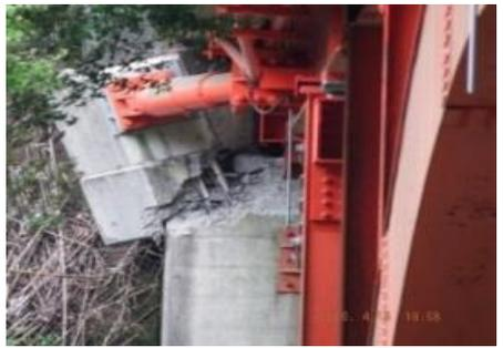
写真-1 曲線橋のゴム支承等の破断
