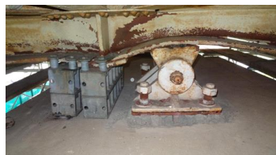
写真-1 支承部の損傷及び橋脚の傾斜 (九州自動車道・木山川橋)
