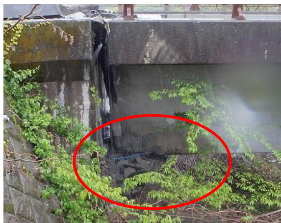
写真-1 橋梁周辺での大規模な斜面崩壊(上) A2橋台側桁端部の損傷(下) (村道栃の木～立野線・阿蘇長陽大橋 あそ ちやうよう )
