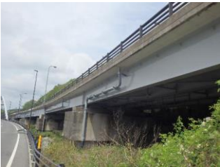
写真-4 阿蘇口大橋 (国道57号)
