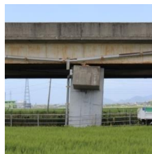
写真-1 支承部の損傷及び橋脚の傾斜 (九州自動車道・木山川橋)
