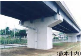
写真-3 国道3号 跨線部
