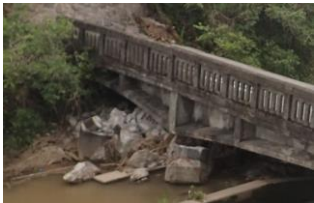
写真-2 平田・小柳線 田中橋
