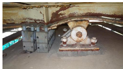
写真-1 支保部の損傷及び橋脚の傾斜 (九州自動車道・木山川橋)
