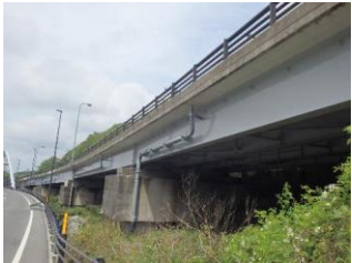
写真-4 阿蘇口大橋 (国道57号)
