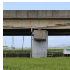
写真-1 支保部の損傷及び橋脚の傾斜 (九州自動車道・木山川橋)
