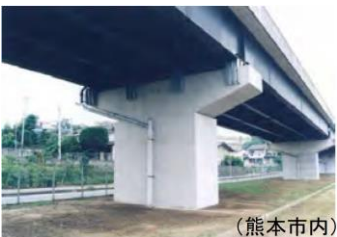
写真-3 国道3号 跨線部
