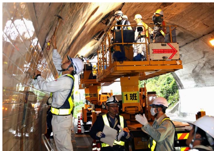
トンネル点検講習会 現場実習状況
