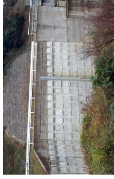
盛土(補強土壁)
