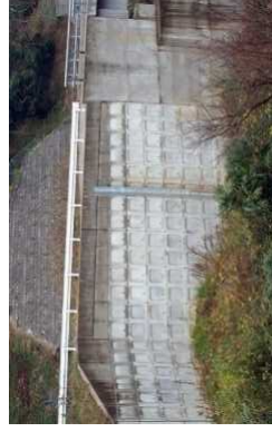
盛土（補強土壁）
