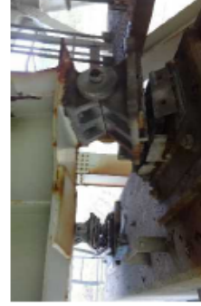
橋梁の支承・主桁の損傷 （大分自動車道・並柳橋）
