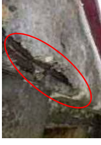
鉄筋の露出
