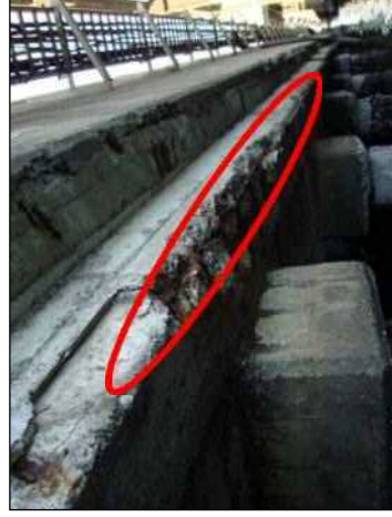
コンクリートの剥離、鉄筋腐食が発生
