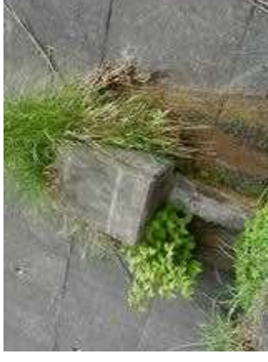
写真 アンカーの頭部からの湧水・雑草の繁茂の例
