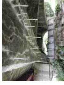
主桁のひびわれ
