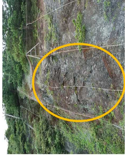
写真 落石防護網の著しい腐食による断面欠損の例
