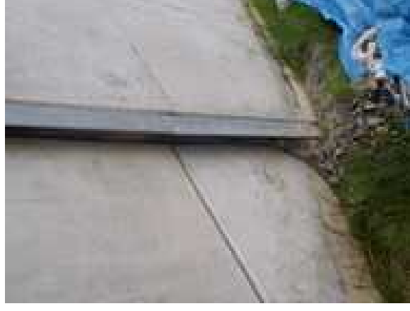
写真 土砂のこぼれ出し例
