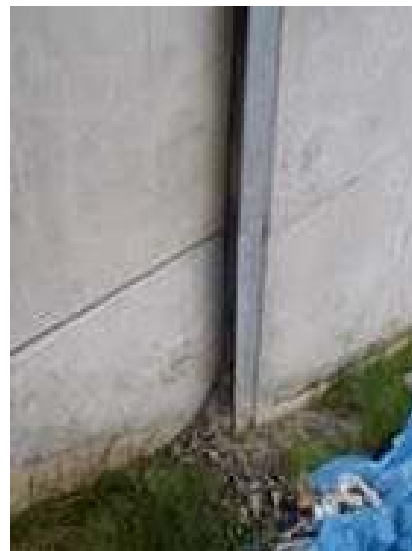
写真 土砂のこぼれ出し例
