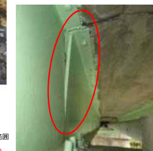
主桁の変形
