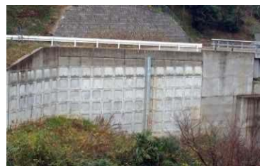
盛土（補強土壁）
