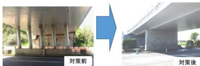
耐震補強の施工例
