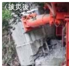
制震ダンパー取付部の損傷
