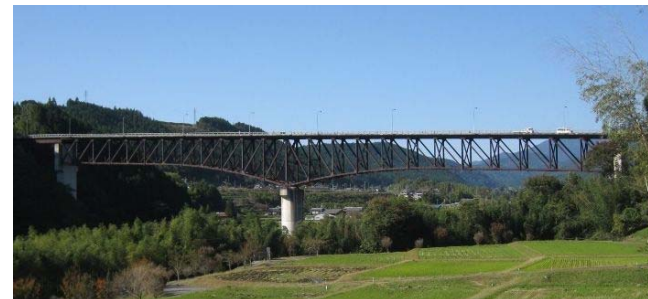
<乙姫大橋の状況>
