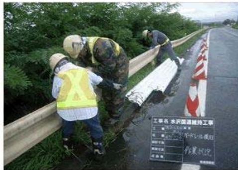
<防護柵の取替>
