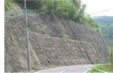
モルタル吹付
