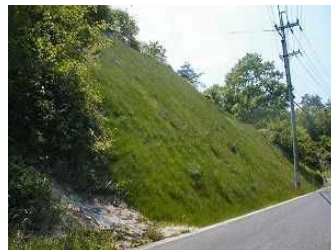
切土(法面保護)
