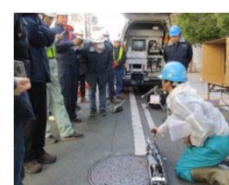
下水道取付管調査の現場試行（岡崎市・豊橋市）
