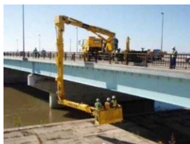
橋梁点検車による点検
