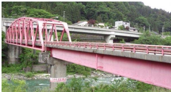
<音沢橋の状況>
