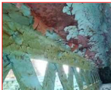
鋼材の腐食
