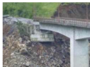
斜面変状による橋台の沈下
