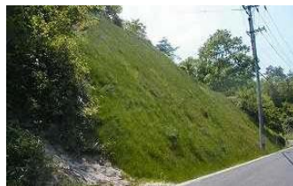
切土（のり面保護）
