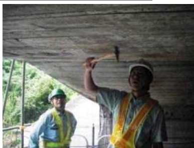
目視及びハンマーによる打音検査
