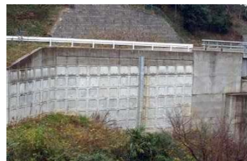
盛土(補強土壁)
