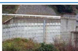
盛土 (補強土壁)
