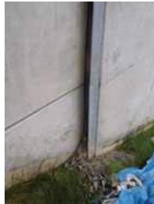
写真 土砂のこぼれ出し例
