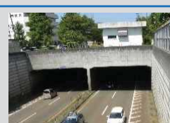
大型ボックスカルバート
