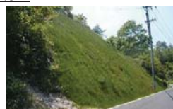
切土 (のり面保護)
