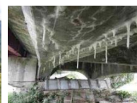
主桁のひびわれ
