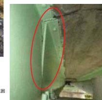
主桁の変形
