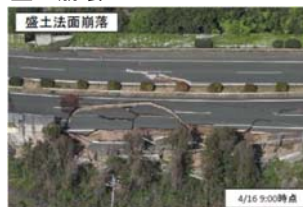
九州自動車道 益城町
