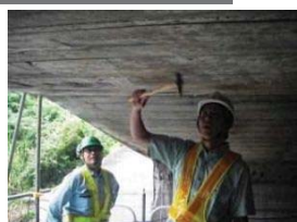
目視及びハンマーによる打音検査
