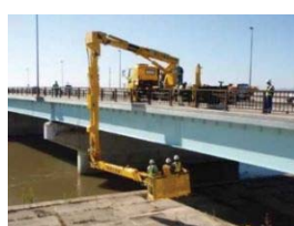
橋梁点検車による点検
