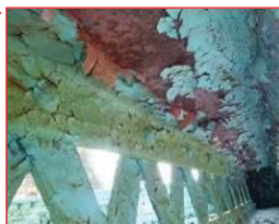
鋼材の腐食
