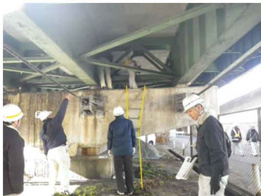
現地実習の状況
