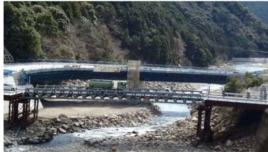
平成23年9月台風12号による紀伊半島大水害の影響により寸断された国道311号の迂回道路として応急組立橋を架設
