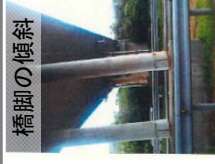
写真-7 九州自動車道を跨ぐ跨道橋(神園橋)
