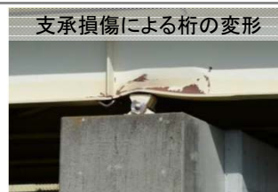
写真-5 九州自動車道 (木山川橋)
