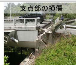
写真-6 熊本高森線 (桑鶴大橋)
