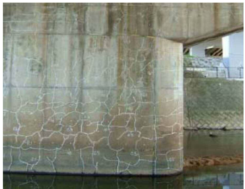
アルカリ骨材反応によるひびわれ
