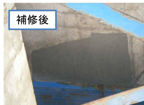
床版下面の補修 (断面修復)
