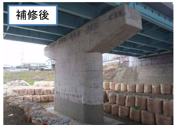
橋脚の補修(断面修復・ひびわれ注入・表面保護等)
