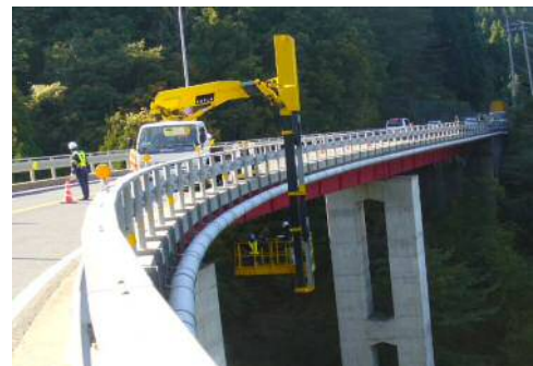
橋梁点検車による定期点検
