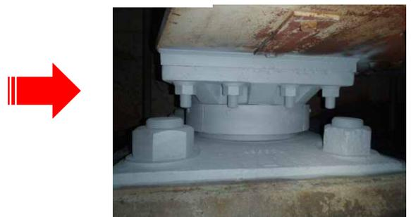
金属溶着による防錆処理
