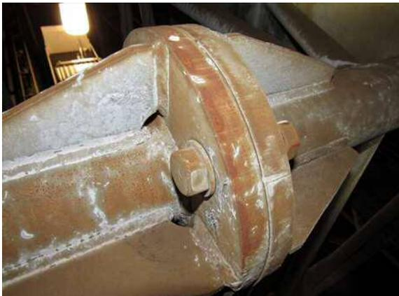
支柱基部の腐食
