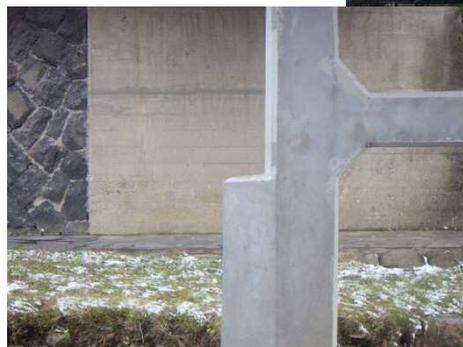
橋脚の補修(断面修復工)
