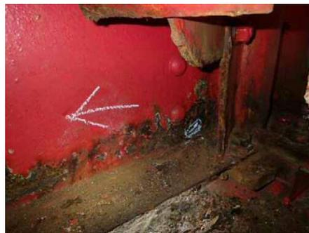
主桁の腐食
