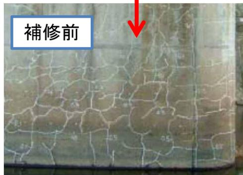
橋脚の損傷(ひびわれ)
