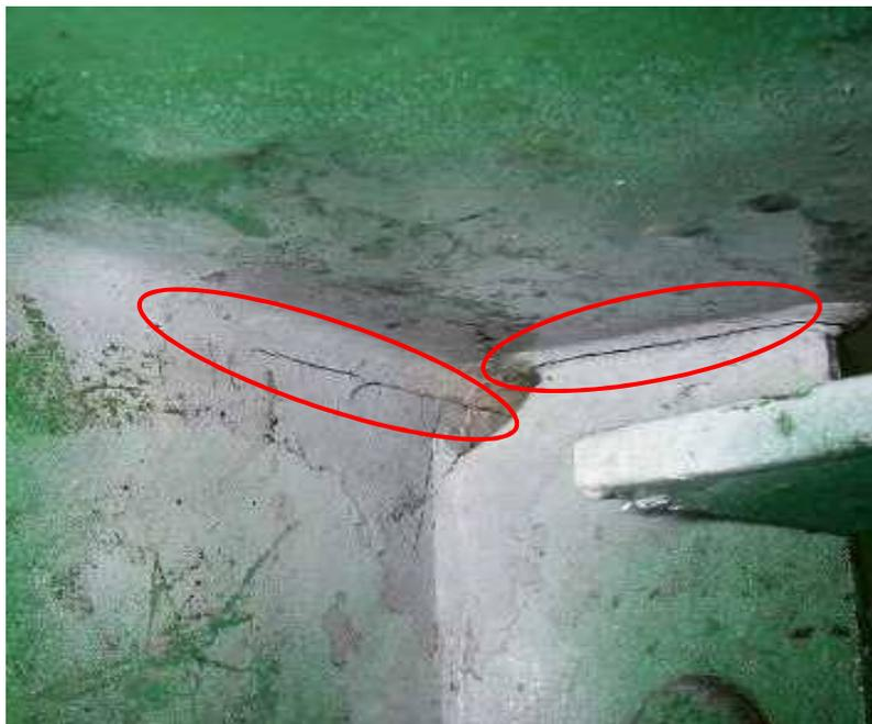
主桁の鋼部材に発生した疲労亀裂
