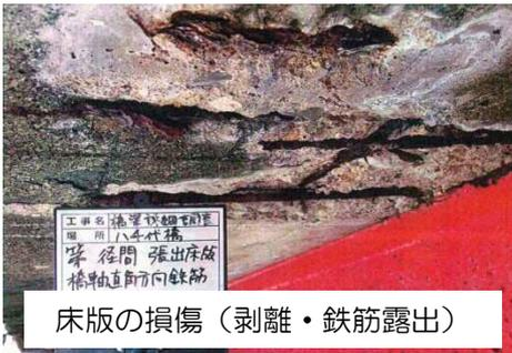
床版の損傷(剥離・鉄筋露出)
