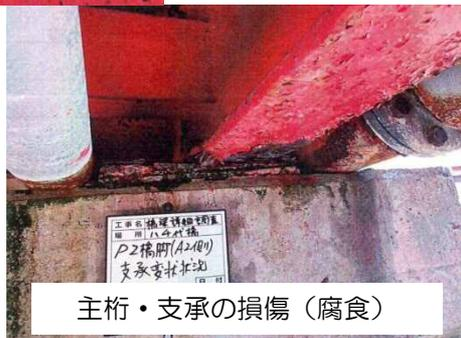
主桁・支承の損傷(腐食)
