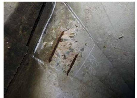
剥離・鉄筋露出
