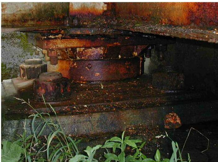
支承の損傷（腐食）
