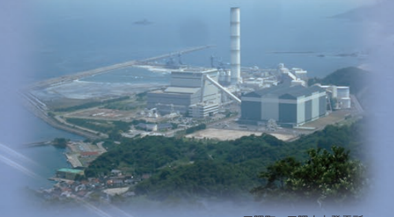
三隅町：三隅火力発電所
